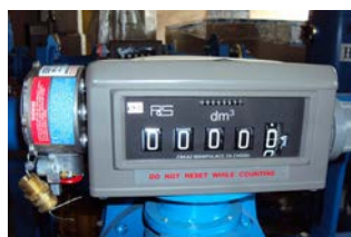
Отсчетное устройство с датчиком импульсов
